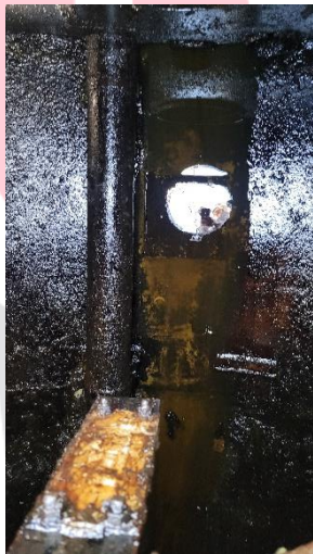
Camión Patente NOW 210: Cisterna no apta para alimentos- Presencia de óxido
